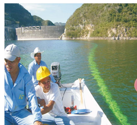
使用FL30测试水库大坝是否渗漏
